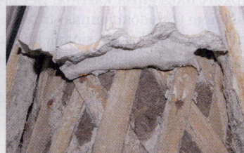
Te var redzēt, ka nekas nav tāds, kā izskatās. Kolonnas.
